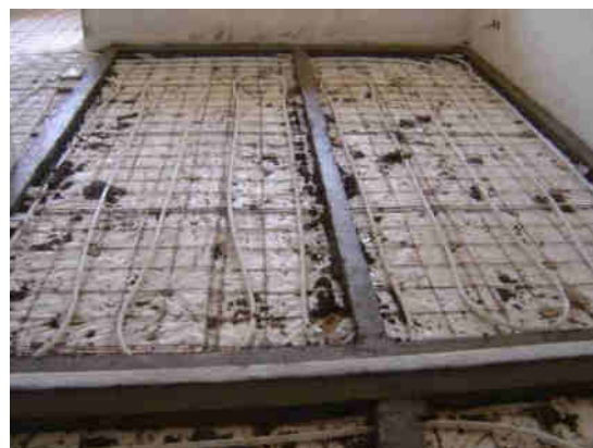
تصویر ۶. اجرا سیستم گرمایش از کف بعد از تقسیم اتاق
