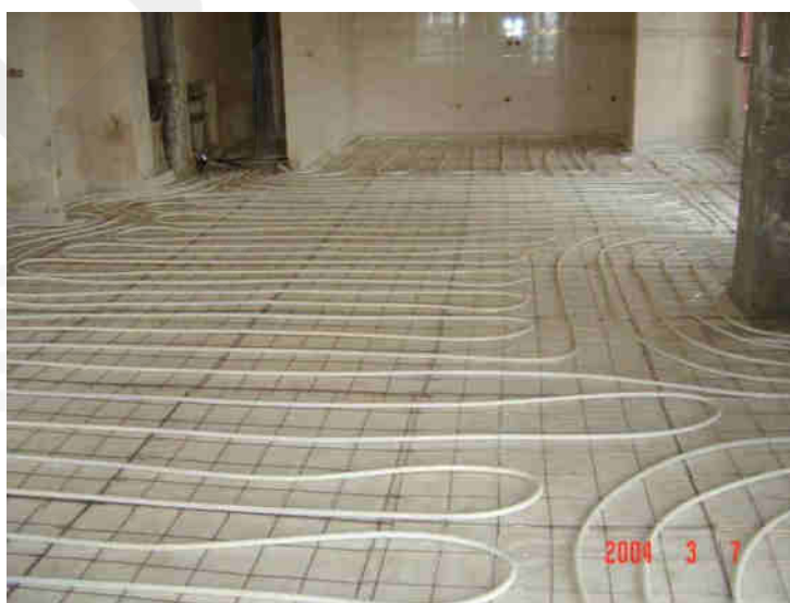
تصویر ۴. اجرای خمهای ۱۸۰ درجه در گرمایش کفی
