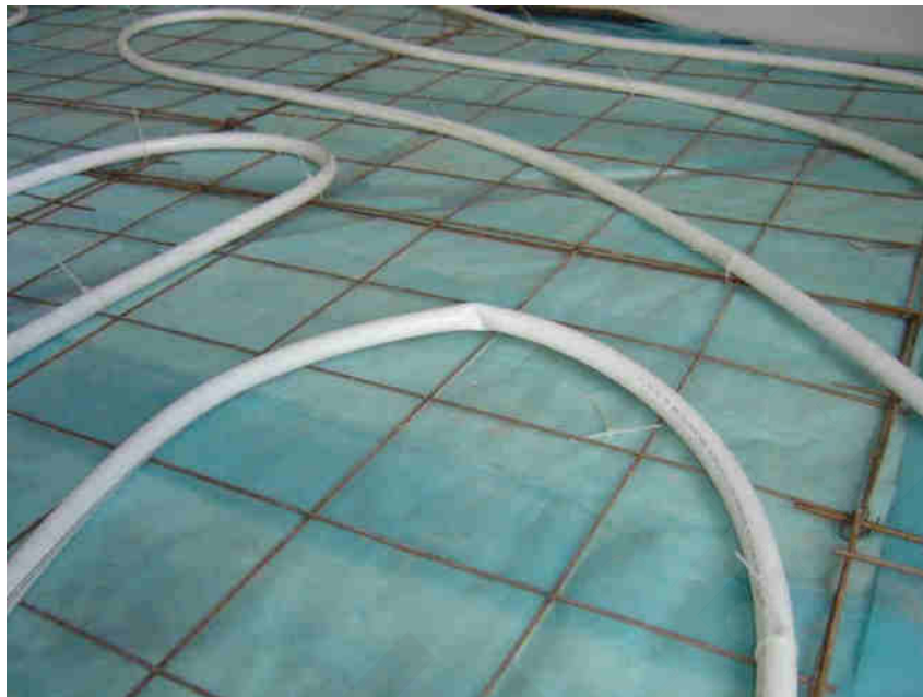
تصویر ۵. مشکلات خمش در لوله های ۵ لایه
