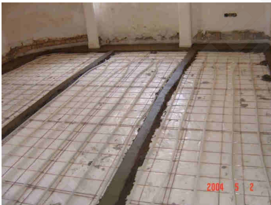
تصویر ۲. قرارگیری درزهای انبساط دیوارهای کناری
