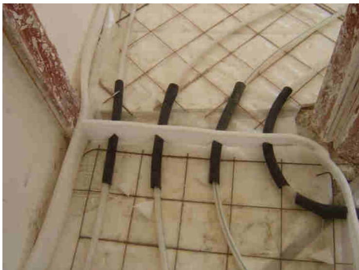
تصویر ۸. استفاده از خرطومی با طول حدود ۴۰ سانتی متر بر روی لوله گرمایش کفی
