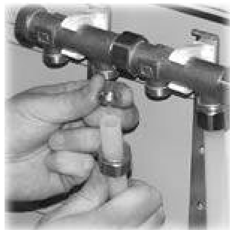
تصویر ۱۵. نحوه اتصال لوله توسط کوپلینگ جهت نصب بر روی مانیفولد
