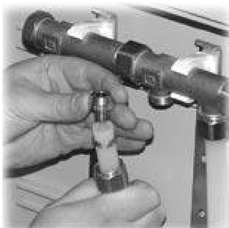
تصویر ۱۵. نحوه اتصال لوله توسط کوپلینگ جهت نصب بر روی مانیفولد
