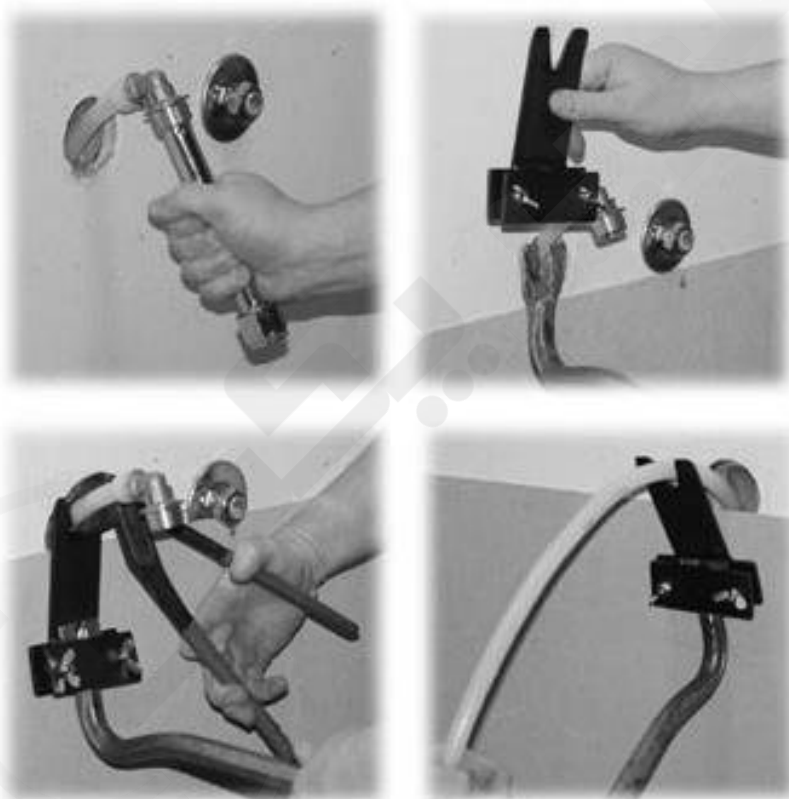
تصویر ۱۷. مراحل تعویض لوله در داخل خرطومی
